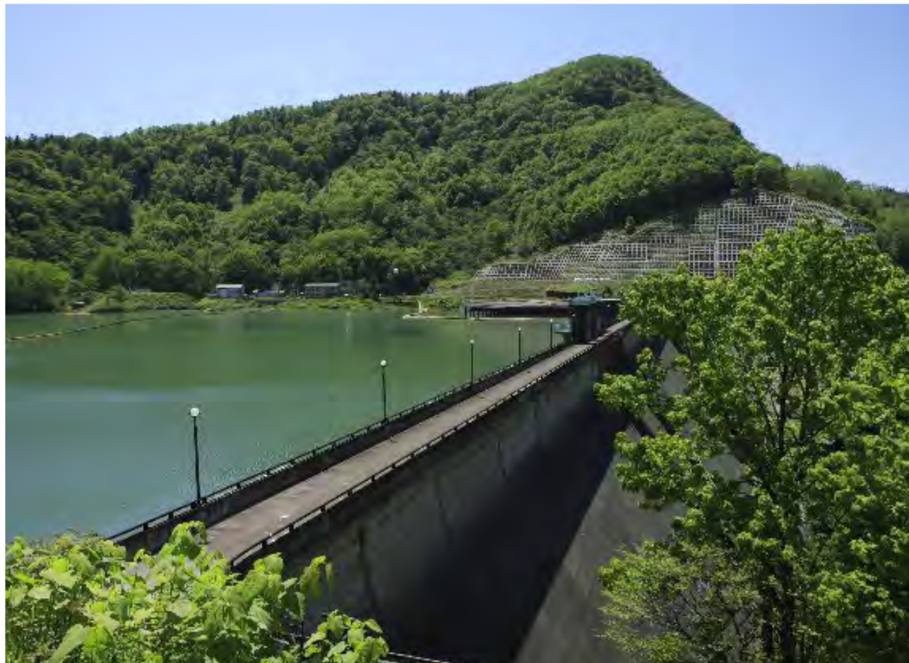
桂沢ダム(昭和32年完成)
