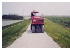
13 堤防天端の維持管理
