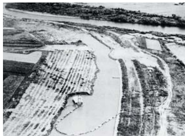
34 石狩川 江部乙第2捷水路の掘削
