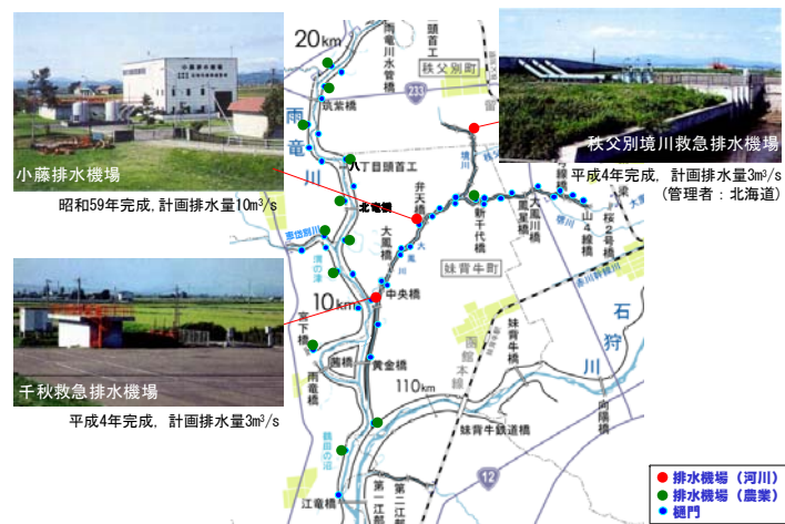
図 1-10 内水排水施設
