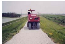
堤防天端の維持管理
