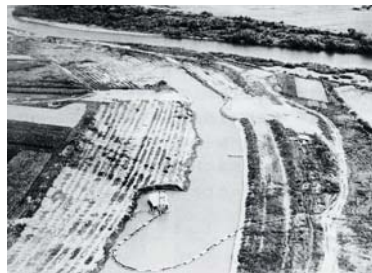
34 石狩川 江部乙第2捷水路の掘削
