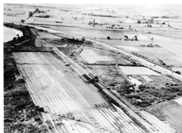
34 雨竜川追分捷水路の掘削
