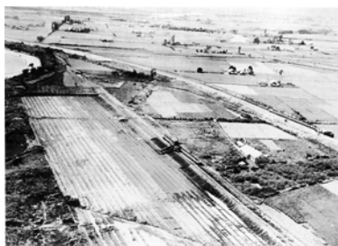
34 雨竜川追分捷水路の掘削
