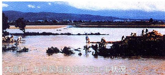
大鳳川 左岸築堤決壊応急工事状況
