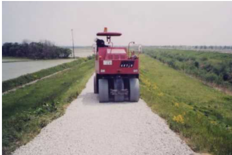
堤防天端の維持管理
