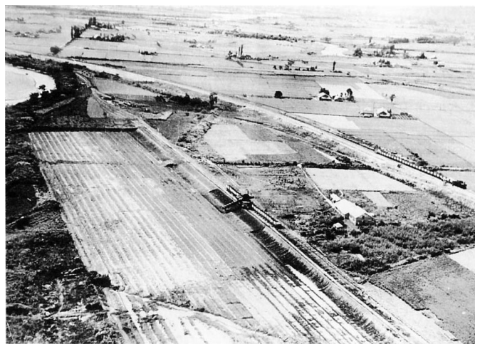
雨竜川追分捷水路の掘削
