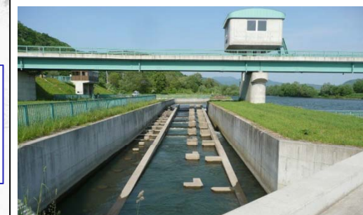
石狩川愛別頭首工魚道(右岸) (平成20年3月竣工)
