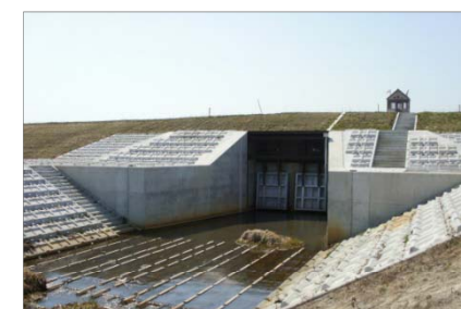
樋門の改築に合わせ耐震性能を 確保(漁太南20号樋門)
