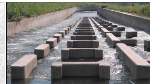
石狩川頭首工魚道(左岸) (平成25年11月竣工)
