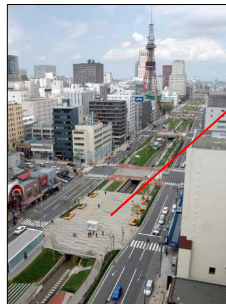
札幌市の関連事業による整備(創成川通)
