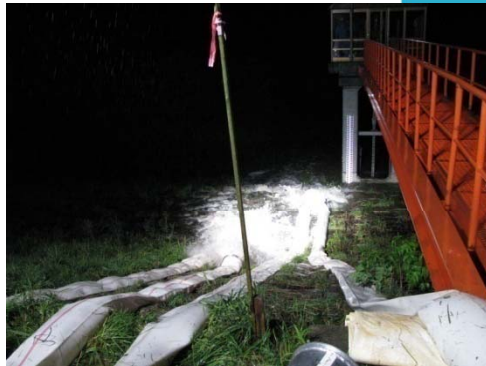
排水ポンプ車稼働状況(夜間作業)
