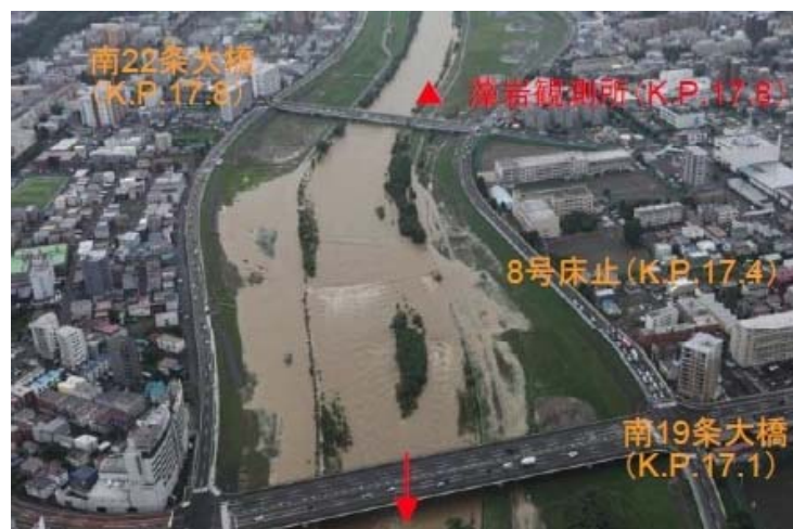
【高水敷の冠水状況(KP14～KP17付近)】
