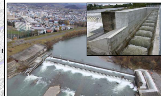
旧花園頭首工魚道(新設左岸) (平成23年8月竣工)
