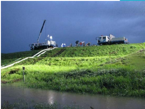
排水ポンプ車稼働状況
