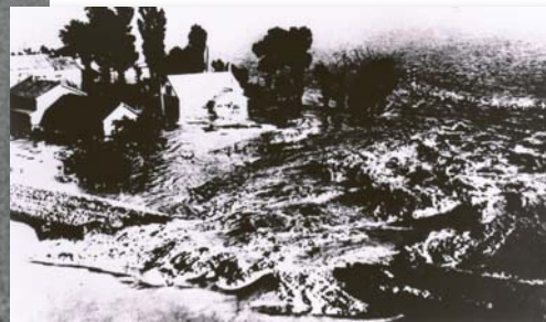
石狩川左岸 大曲左岸築堤の越水破堤状況 出典:「石狩川流域発展の礎・治水」より
