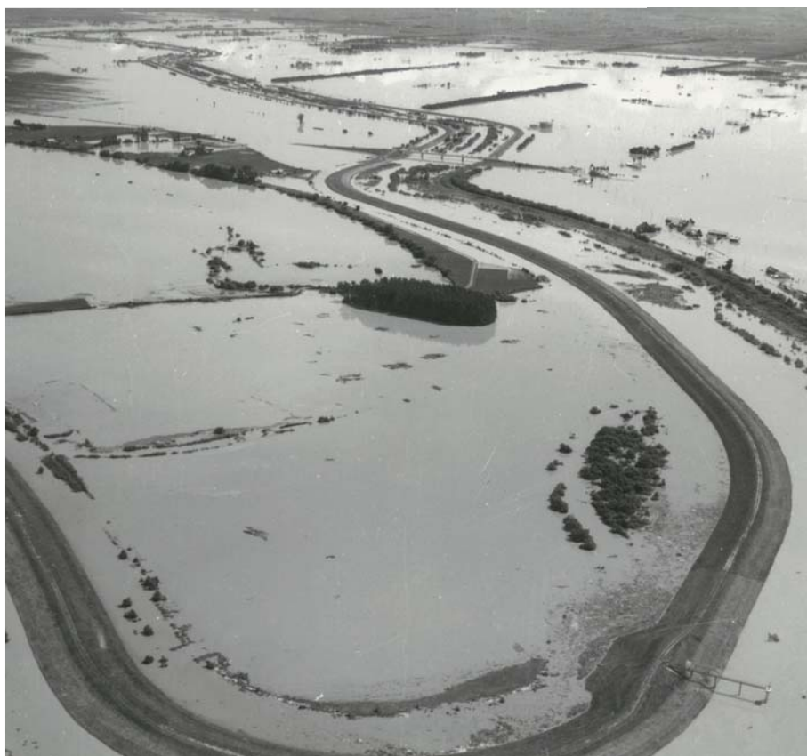
産化美唄川の洪水氾濫 下流から上流を望む 岩見沢河川事務所蔵
