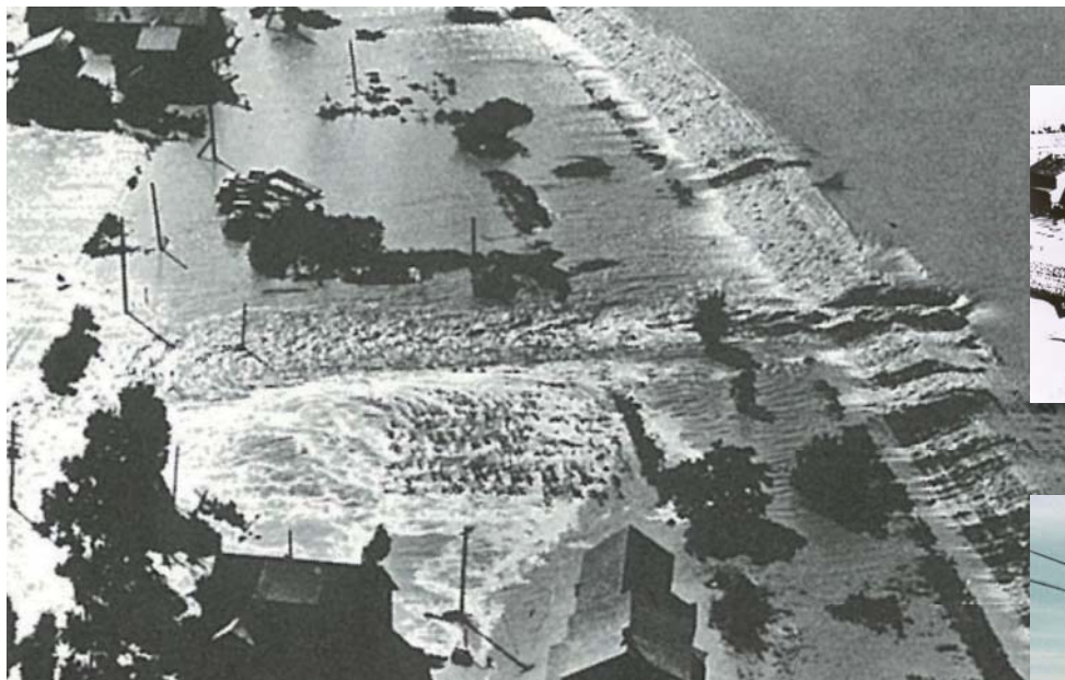
石狩川左岸 大曲左岸築堤の越水破堤状況 出典:「石狩川流域発展の礎・治水」より
