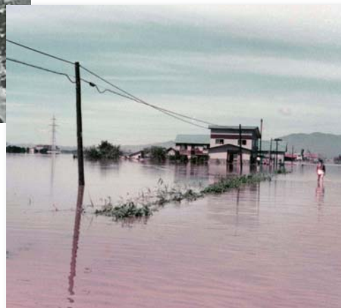
産化美唄川 左岸市道7線7号道路路氾濫 岩見沢河川事務所蔵
