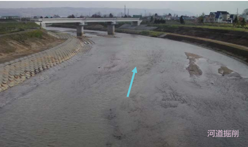
富良野川 施工済み箇所
