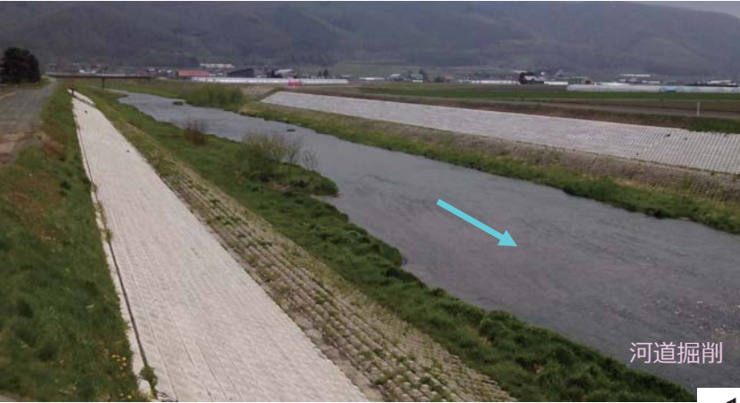
ベベルイ川 施工済み箇所
