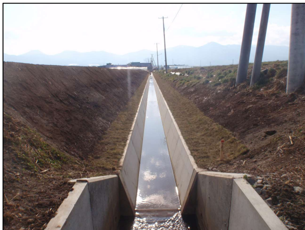
農業用排水路の整備
