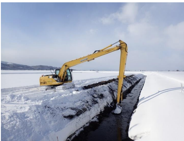
土砂掘削状況
