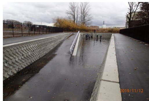
北区東茨戸(雨水貯留池)
