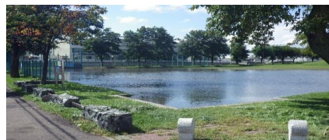
平成26年9月11日大雨時の貯留状況
