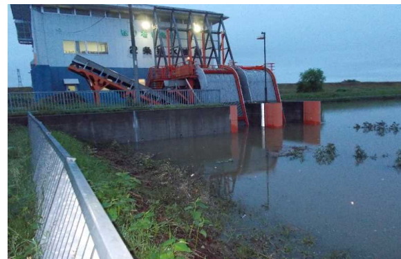
【排水機場の整備】 2条排水機場
