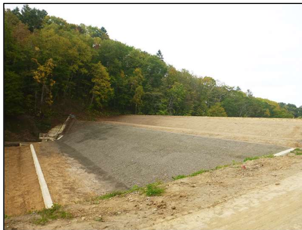
農業用ため池の整備
