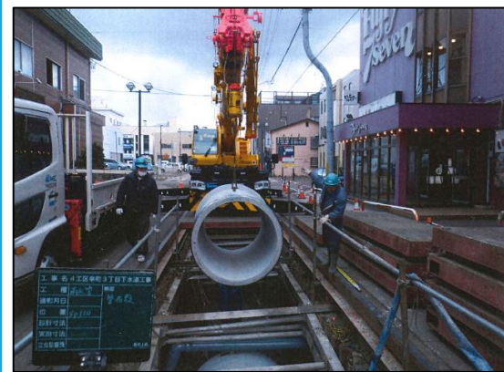
【下水道管敷設状況】
