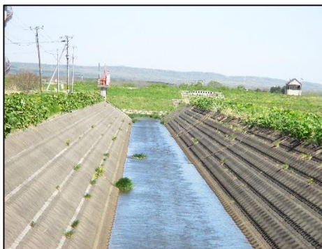
【農業用排水路】
