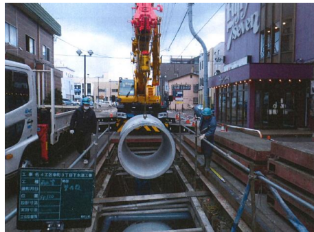
雨水管の整備(千歳市)
