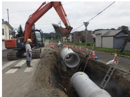
雨水管の整備(砂川市)
