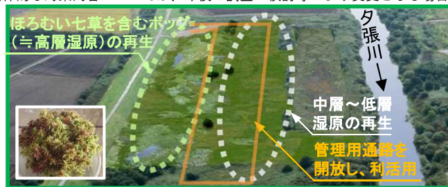
湿性植物を育むポット（高層湿原）を中心とした湿原環境の再生（夕張川幌向地区）
