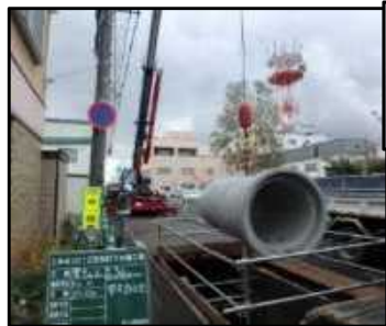
下水道雨水管の整備
