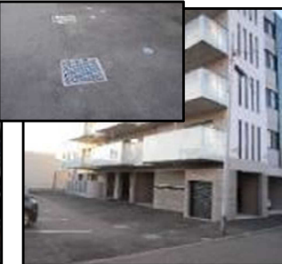
浸透枳の設置
