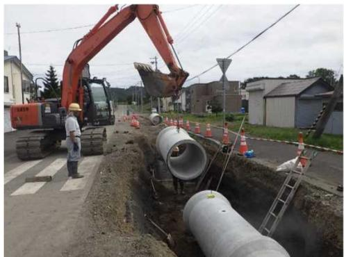
雨水管の整備(砂川市)
