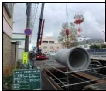
下水道雨水管の整備
