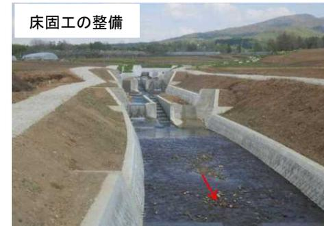
土砂・洪水氾濫を防止するための砂防関係施設の整備
