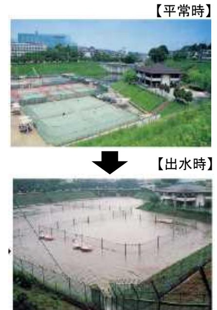
雨水貯留浸透施設の例(防災調整池) 5
