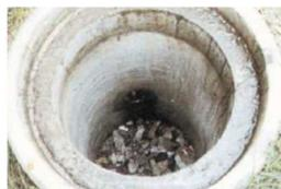
雨水ますの底部に穴を開け、その周囲に砂利を敷きならべたもの
