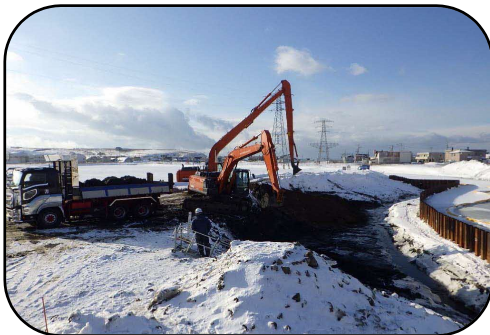
望来川(掘削工)
