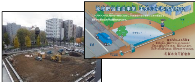
貯留施設の整備
