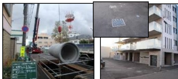
下水道雨水管の整備
