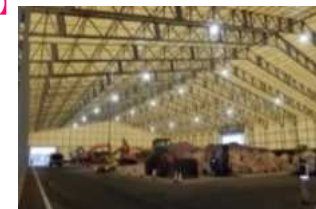
熊本地震時の熊本港における廃棄物仮置
