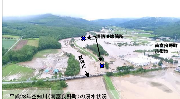
平成28年空知川(南富良野町)の浸水状況
