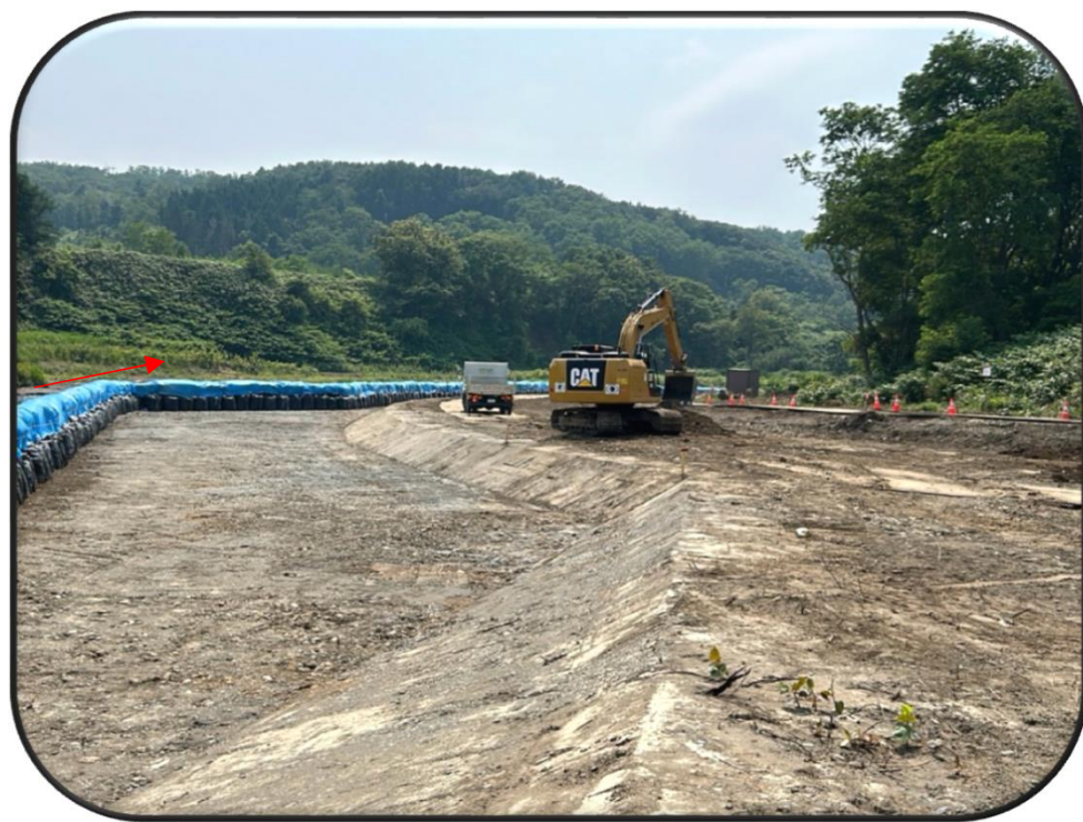
厚田川(掘削工)
