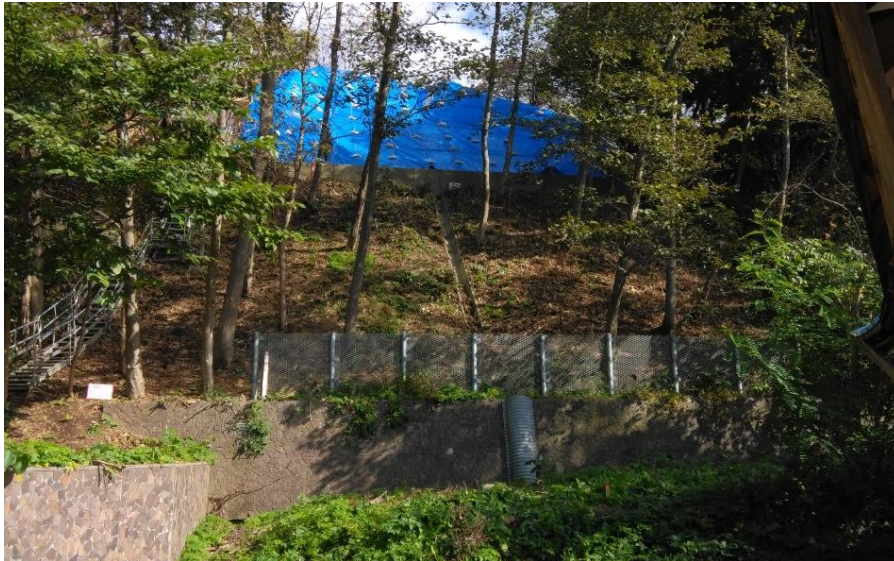
山腹工（張工等）の実施状況 （小学校地先・石狩市）
