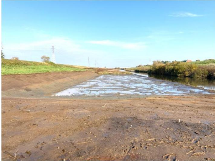
厚別川河道掘削
