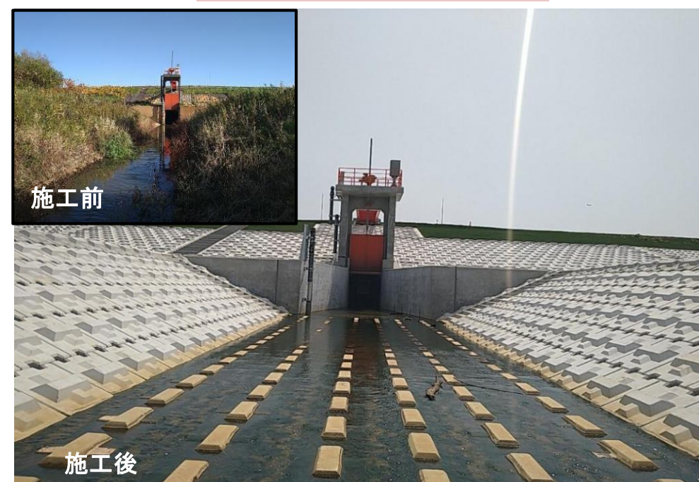
中央長都樋門(改築工事)
