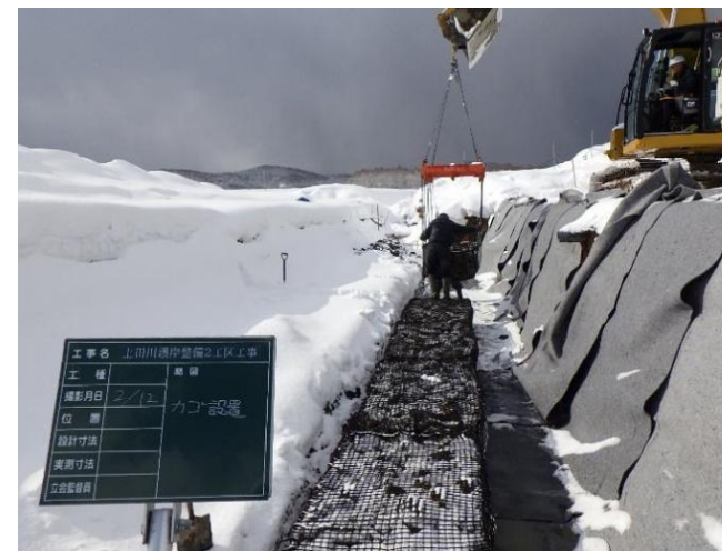
・上田川護岸整備工事
