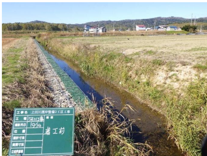
・上田川護岸整備工事
