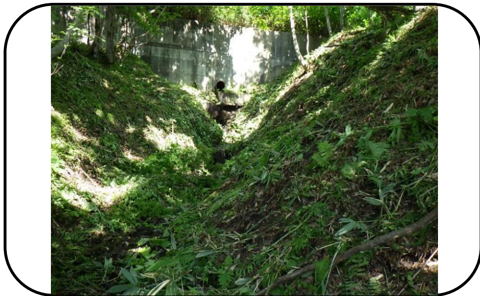
床固工実施前
