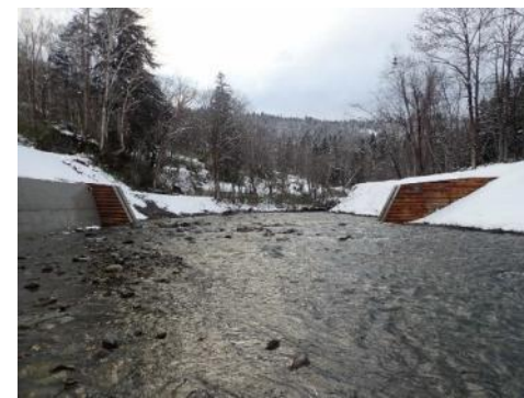
溪間工(治山ダム)の設置による溪床の安定化
