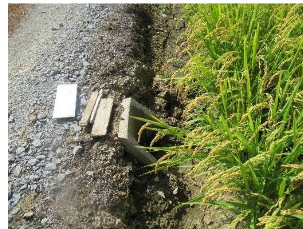
・落水量調整装置等を活用
