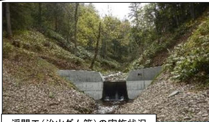
溪間工(治山ダム等)の実施状況
