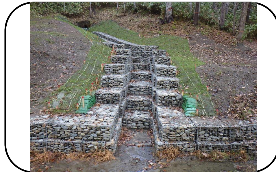
流路工実施後
