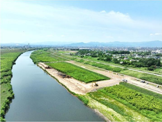
豊平川雁来築堤掘削
