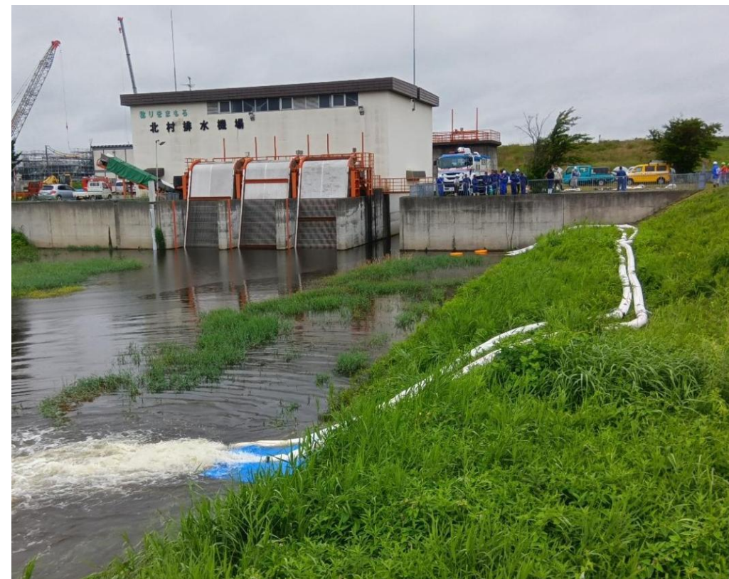
ポンプ車の排水状況
