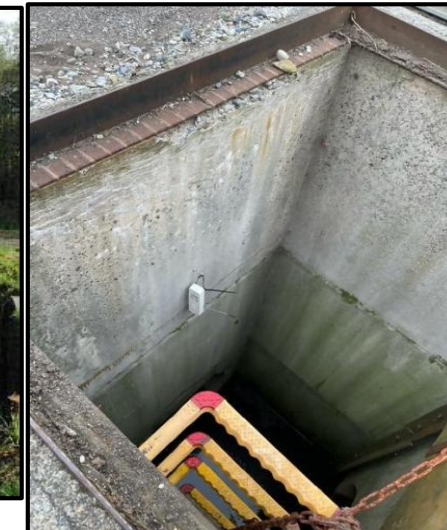
ワンコイン浸水センサの設置
