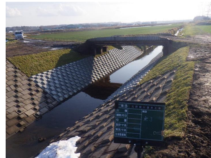
■護岸改修(元野幌川)
