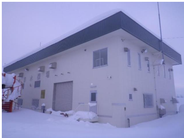
・碧水排水機場
