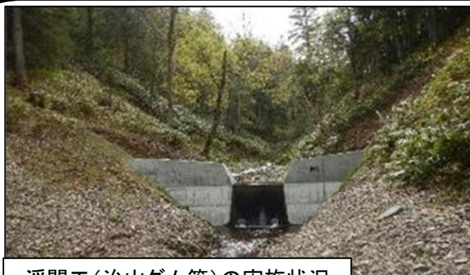
溪間工(治山ダム等)の実施状況
