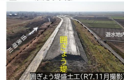
■ 盛土工(囲ぎよう堤)
