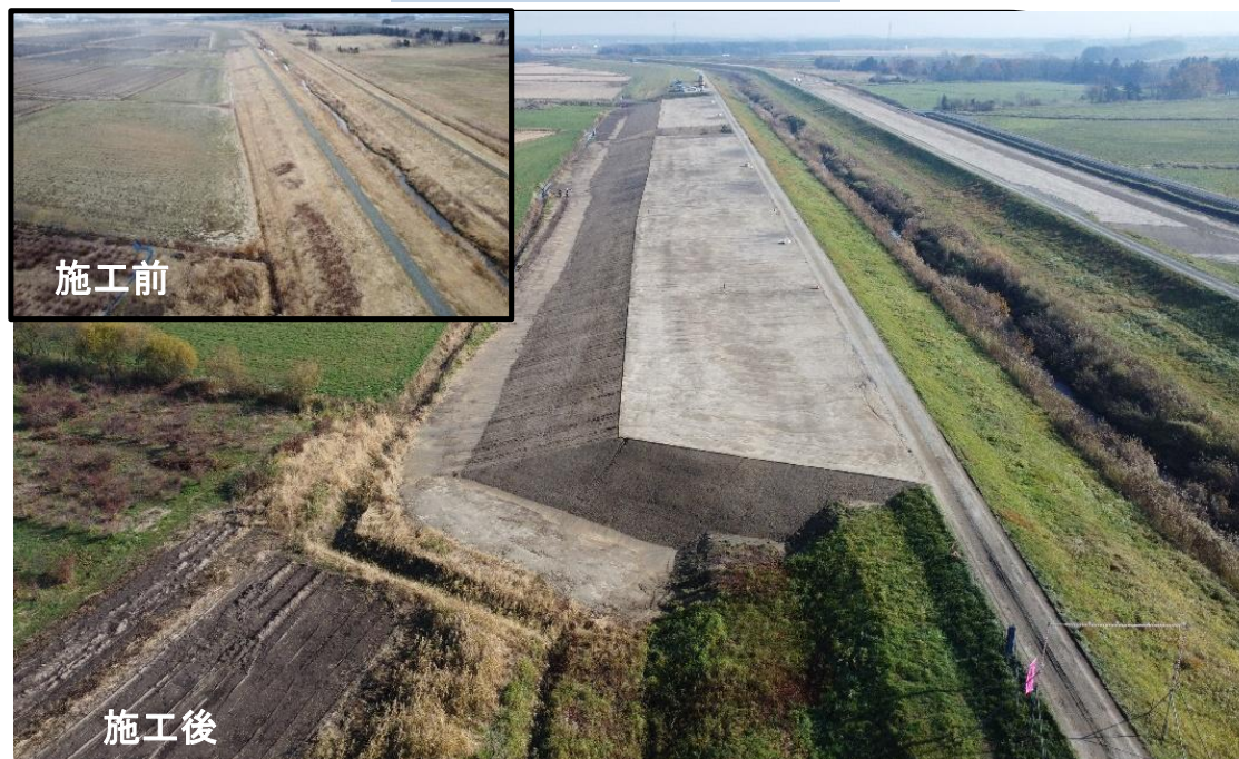
音江別川(堤防整備)
