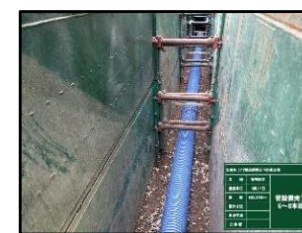
【雨水管敷設状況】
