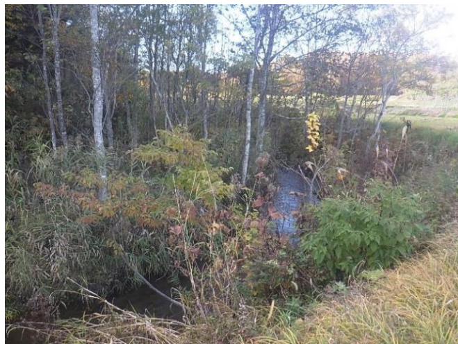
・御料川浚渫工事
