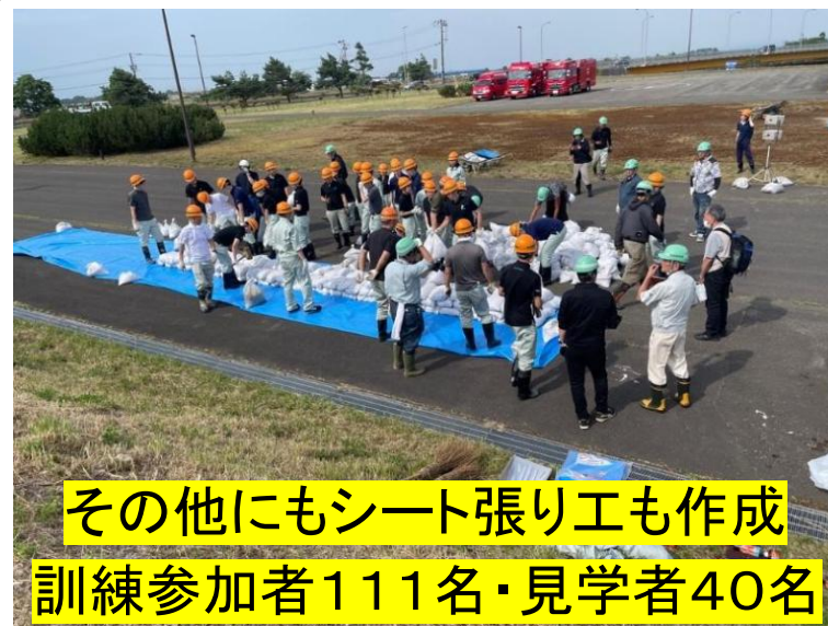
積土のう工作成状況
