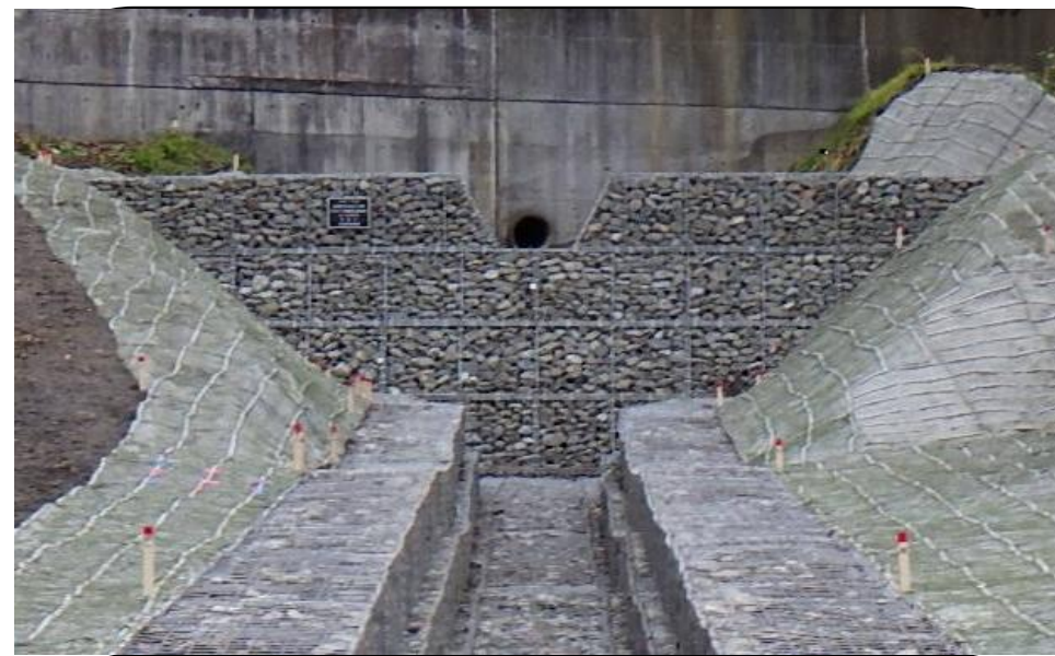
床固工実施後
