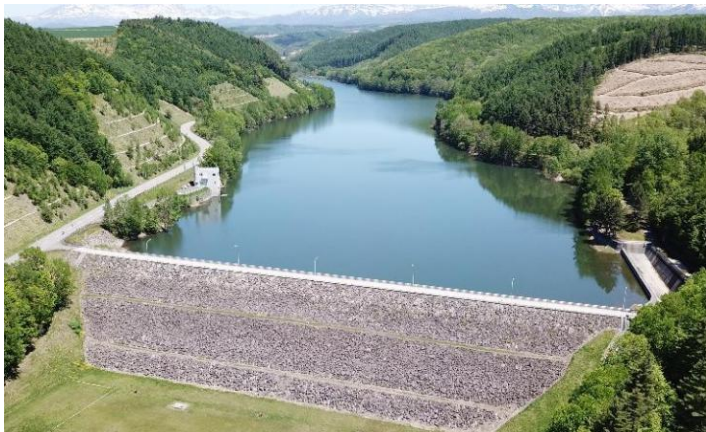
【貯水位運用前】 5月下旬の状況
