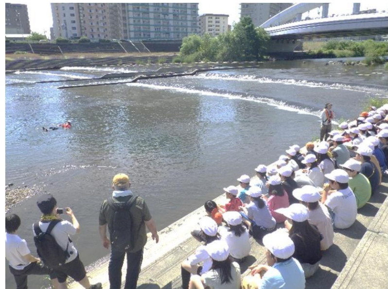
豊平川左岸 幌平橋付近
