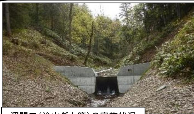
溪間工(治山ダム等)の実施状況
