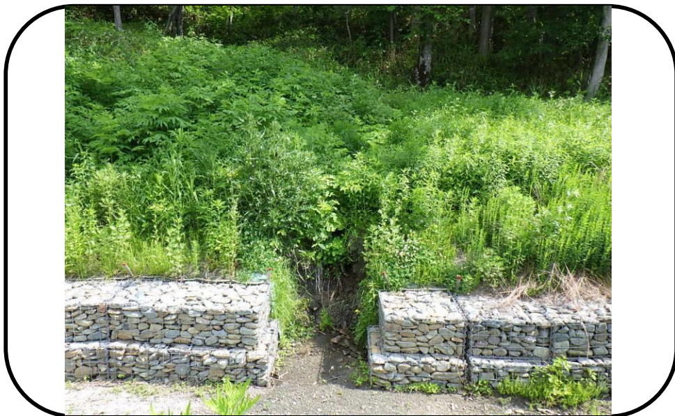
流路工実施前
