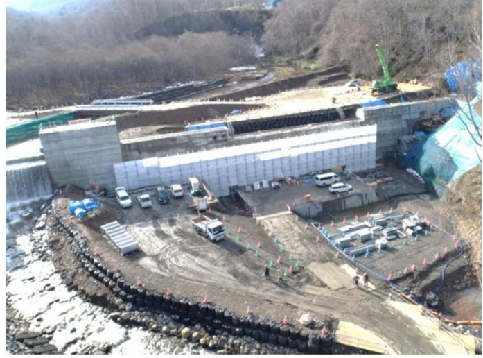
簾舞川御料堰堤改良
