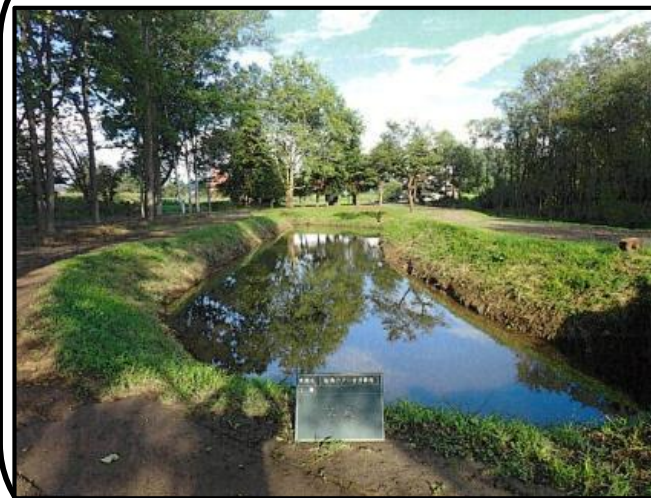
駄馬の沢川での伐開・浚渫
