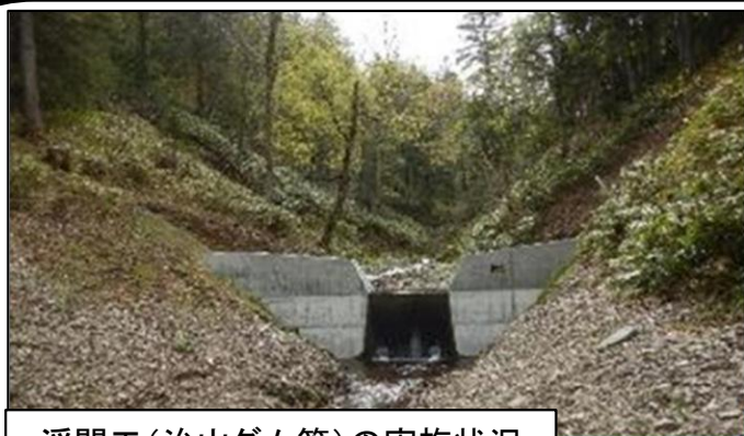
溪間工(治山ダム等)の実施状況
