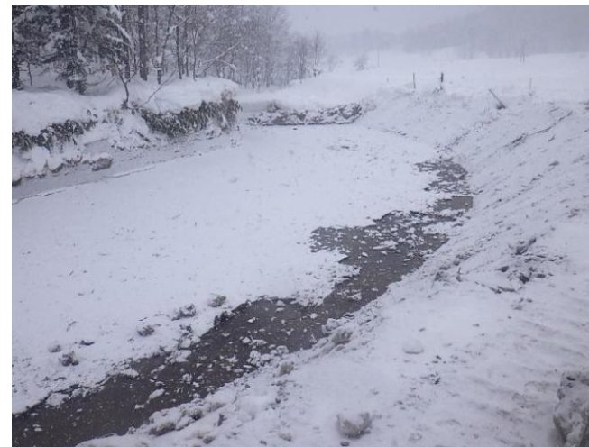
・御料川浚渫工事
