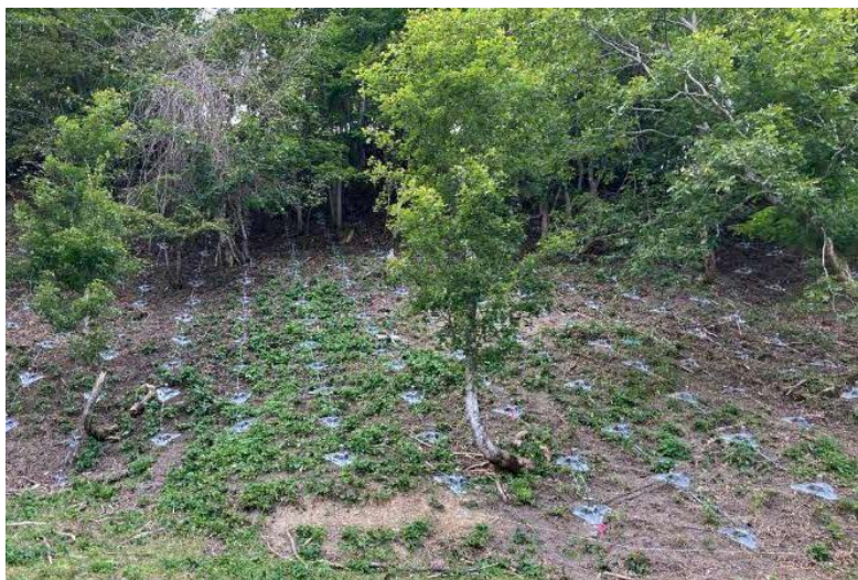
試験農園地先緊急予防治山工事【夕張市】
