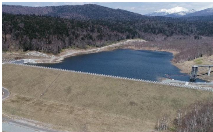
【貯水位運用前】 4月下旬の状況
