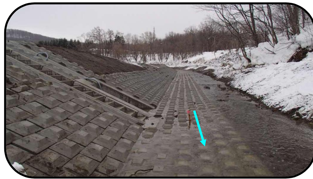
石山川(実施後)
