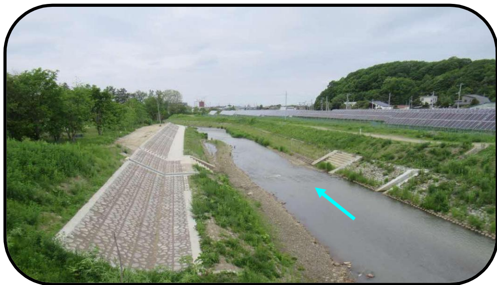
雨煙別川(実施後)
