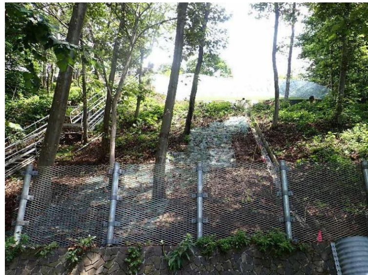
山腹工（張工等）の実施状況 （小学校地先・石狩市）
