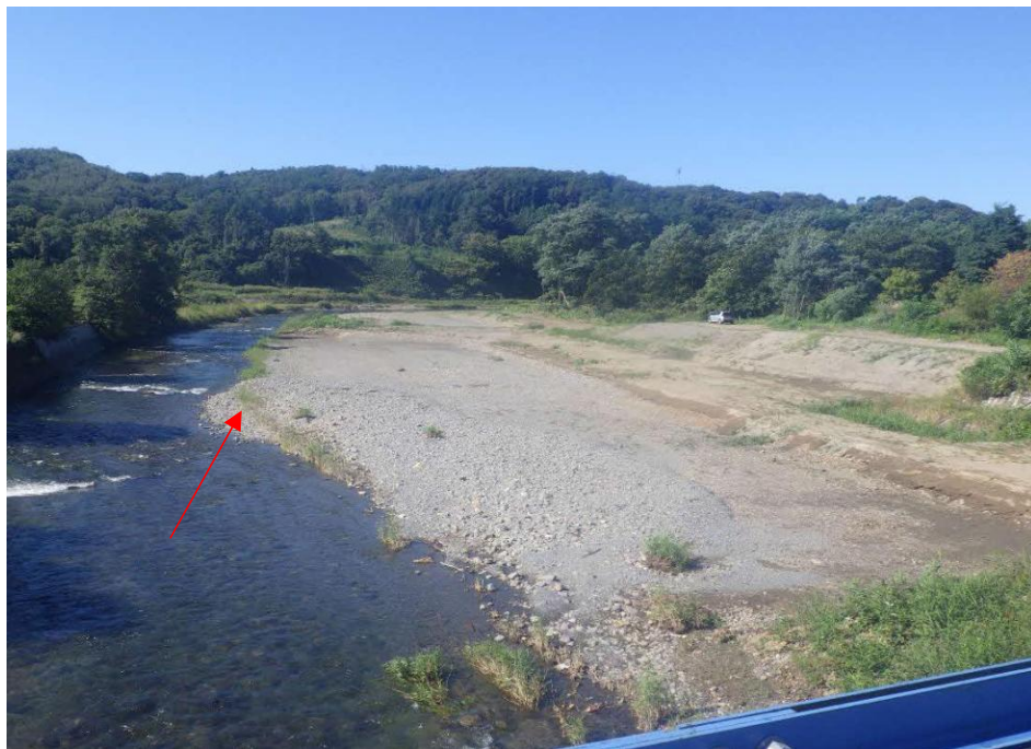
厚田川(掘削工)
