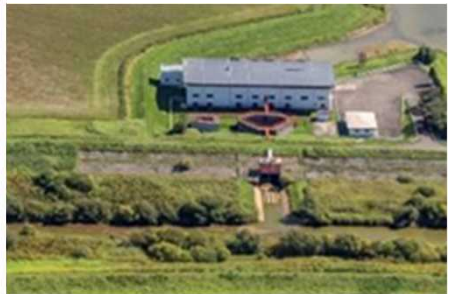
排水機場の排水規制緩和
