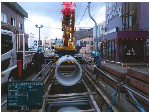
【下水道管敷設状況】
