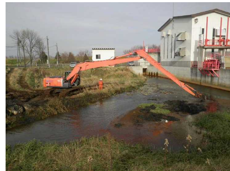
写真：西4線排水機場 導水路床ざらい状況 (H28)
