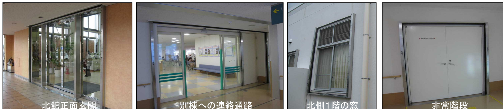
止水板のための角落しとの設置
