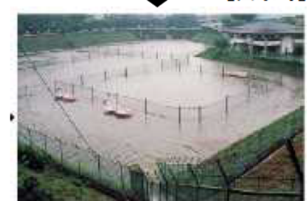
雨水貯留浸透施設の例（防災調整池）
