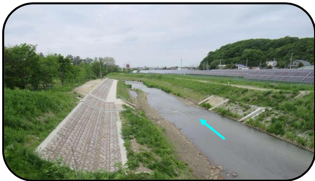
雨煙別川(実施後)
