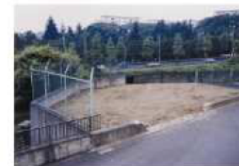
埋め立て後の状況
