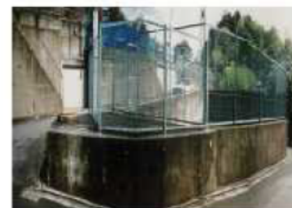
従前の防災調整池
