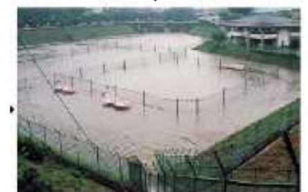
雨水貯留浸透施設の例（防災調整池）
