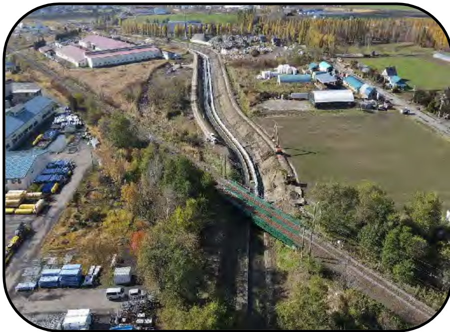
利根別川(掘削工)
