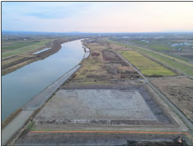
石狩川(河道掘削)
