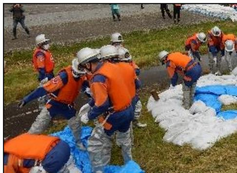
漏水対策工法(月の輪工)
