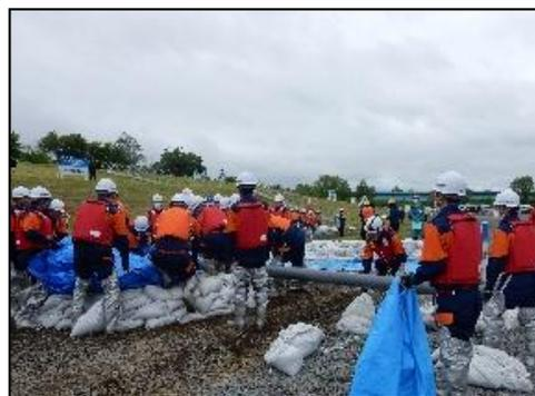
漏水対策工法(釜段工)
