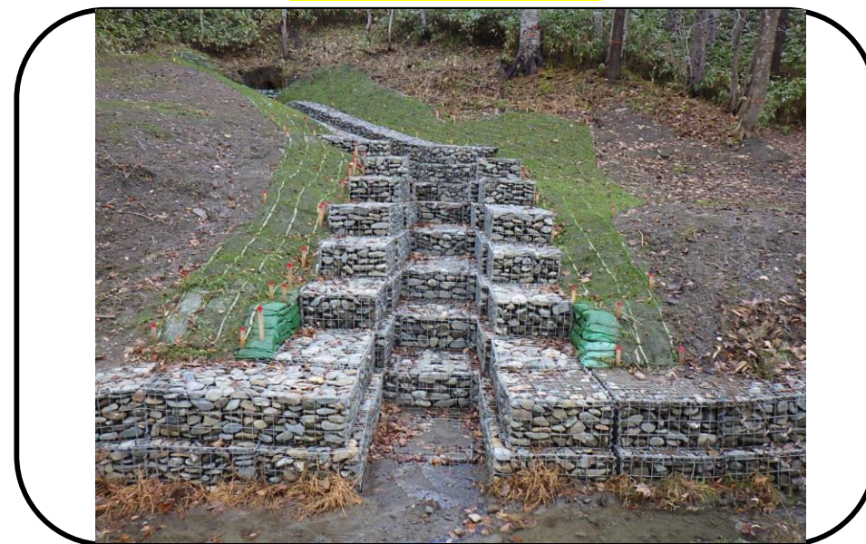
流路工実施後
