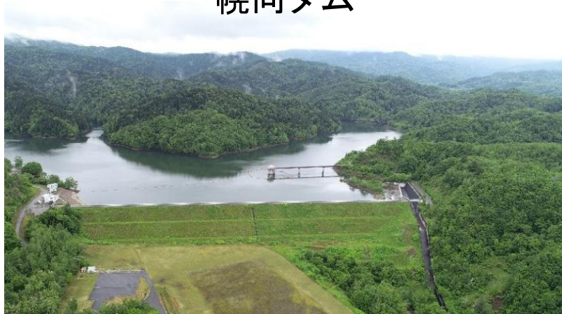
【貯水位運用前】 6月中旬の状況
