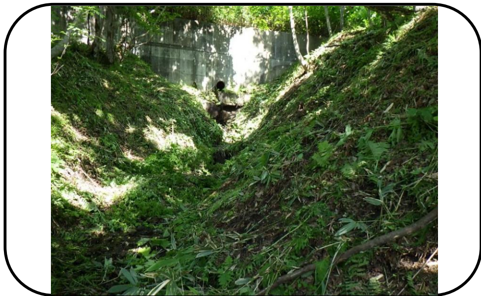
床固工実施前
