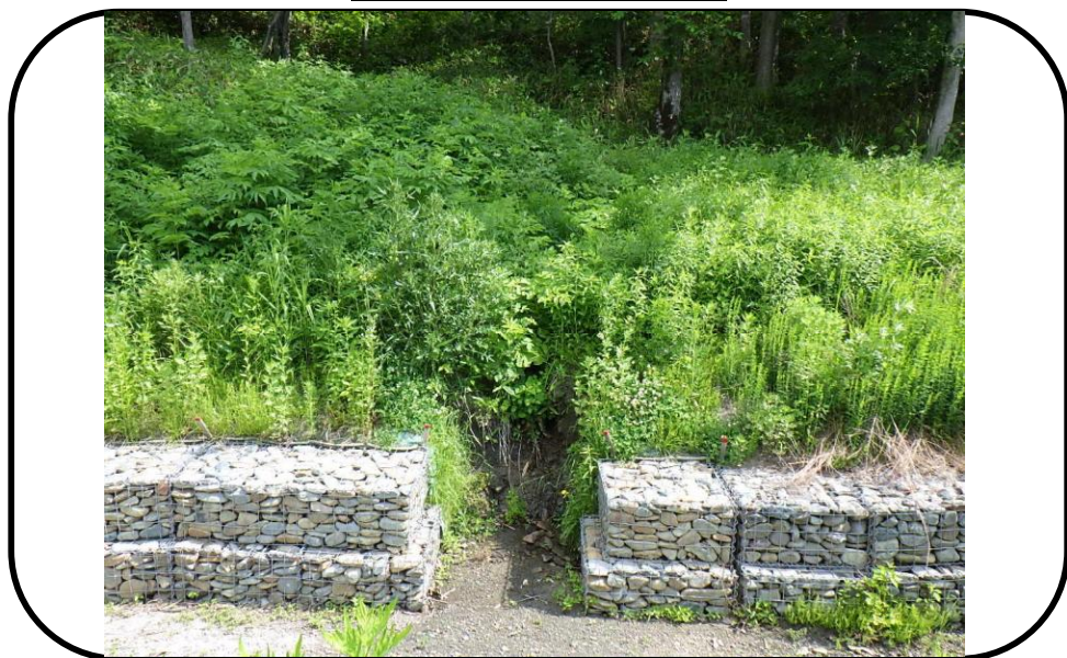
流路工実施前
