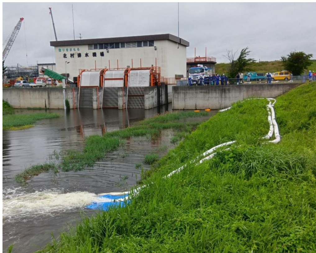
ポンプ車の排水状況
