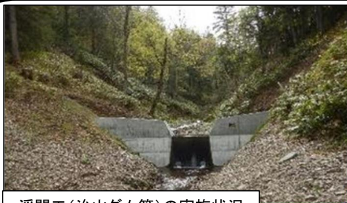
溪間工(治山ダム等)の実施状況
