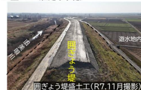
■ 盛土工(囲ぎよう堤)
