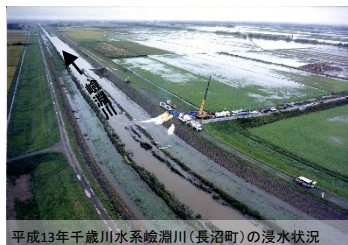
平成13年千歳川水系嶮淵川(長沼町)の浸水状況
