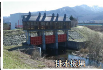
雨水貯留浸透施設
