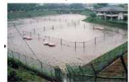
雨水貯留浸透施設の例（防災調整池）5
