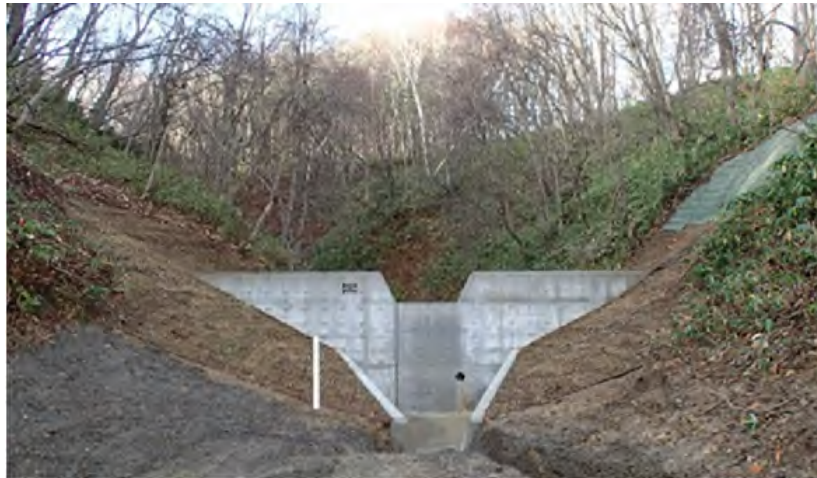
溪間工(治山ダム)の実施状況 (赤ハゲ右の沢・石狩市)
