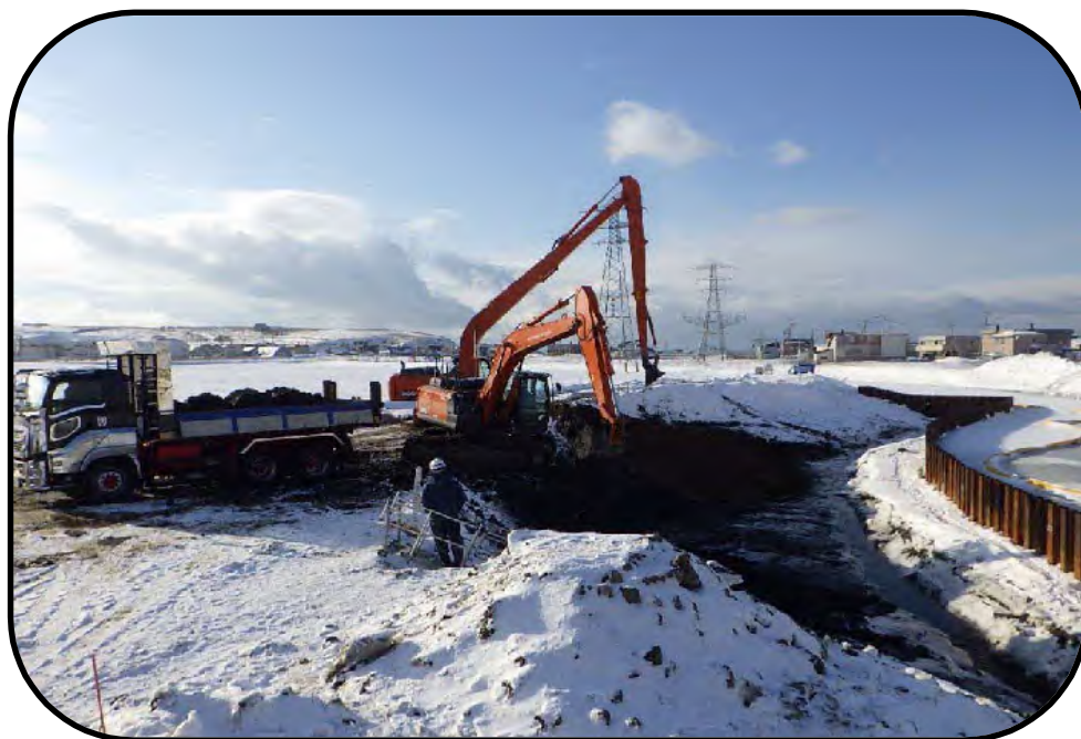
望来川(掘削工)
