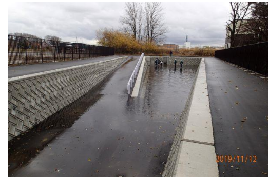
北区東茨戸(雨水貯留池)
