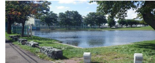
平成26年9月11日大雨時の貯留状況
