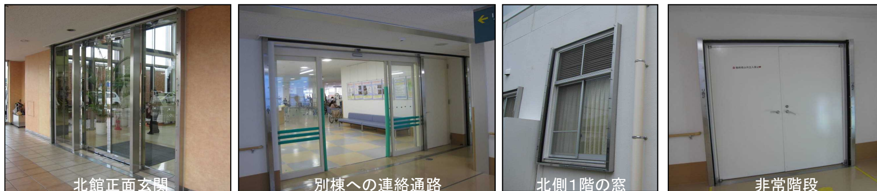
止水板のための角落しとの設置
