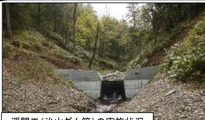
溪間工(治山ダム等)の実施状況
