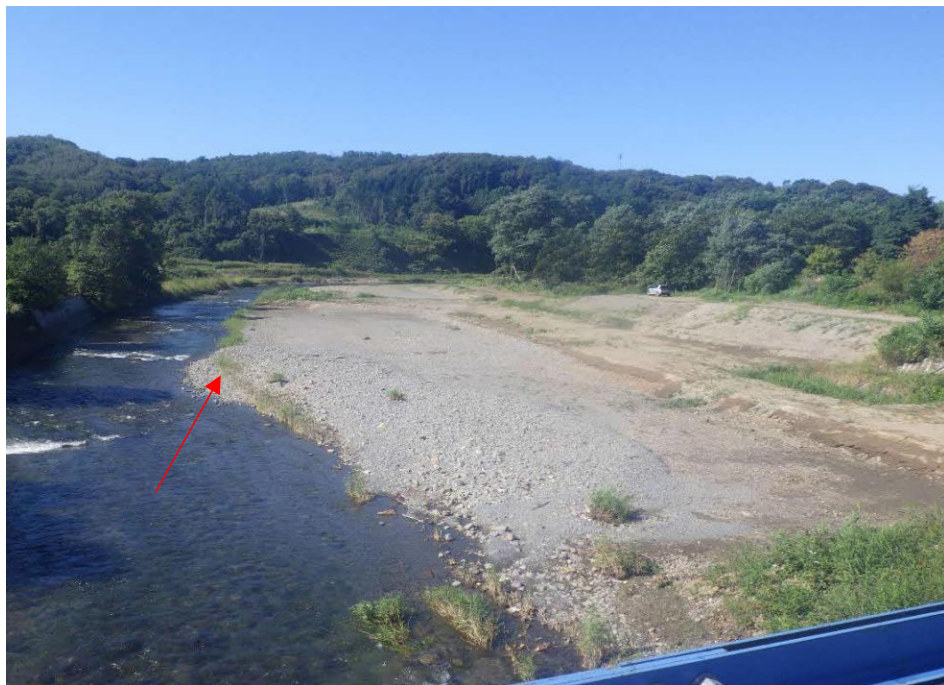
厚田川(掘削工)
