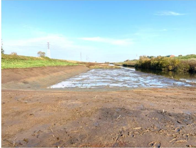
厚別川河道掘削
