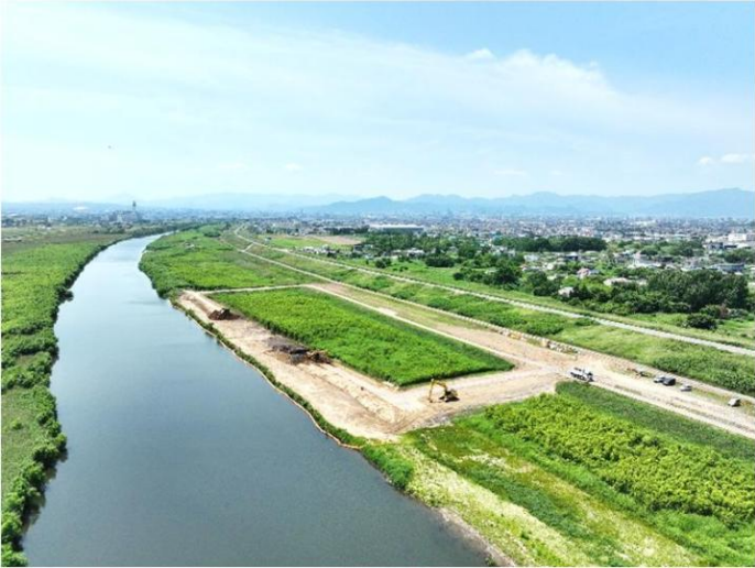
豊平川雁来築堤掘削
