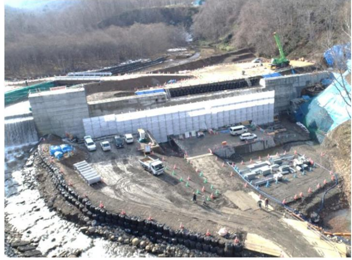
簾舞川御料堰堤改良
