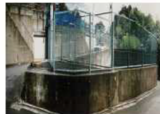
従前の防災調整池
