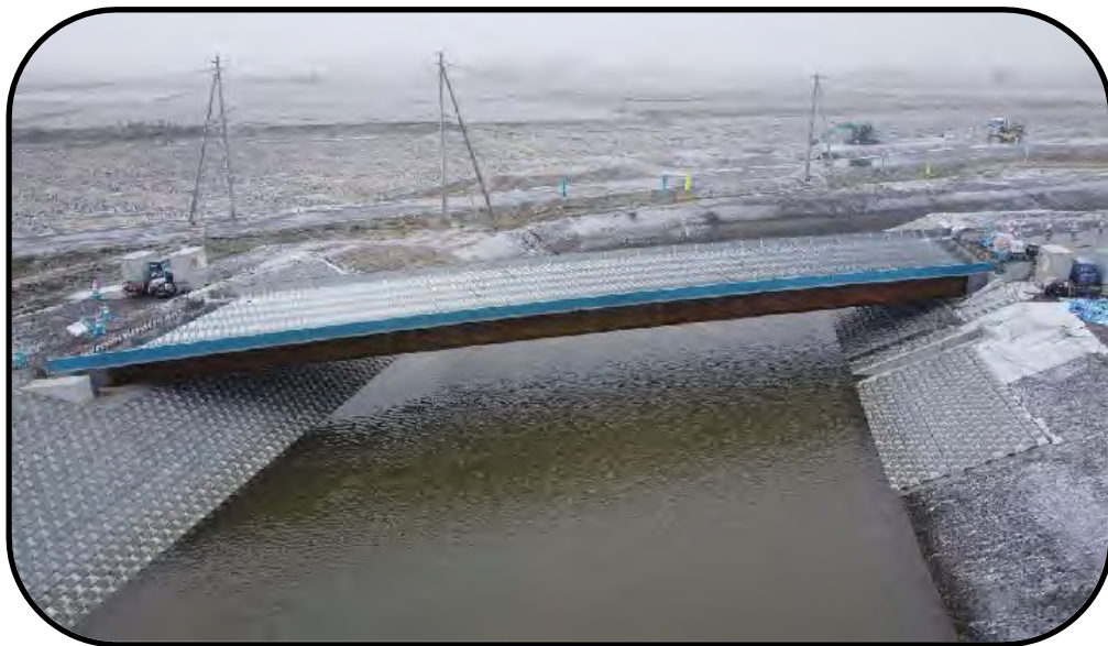
入志別川(掘削工・橋梁架換)
