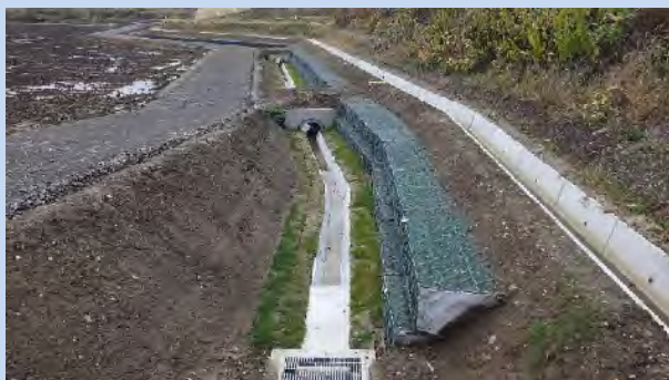
農業用排水路の整備
