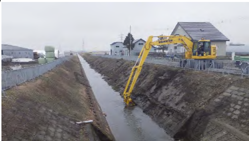
普通河川の河道掘削
