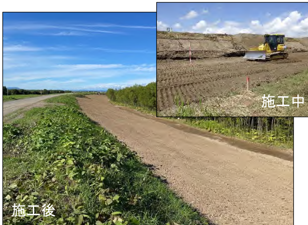
石狩川(堤防整備)
