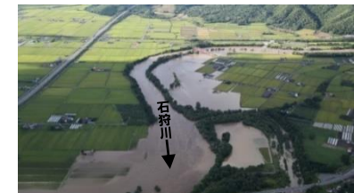
平成28年石狩川(深川市、旭川市)の浸水状況
