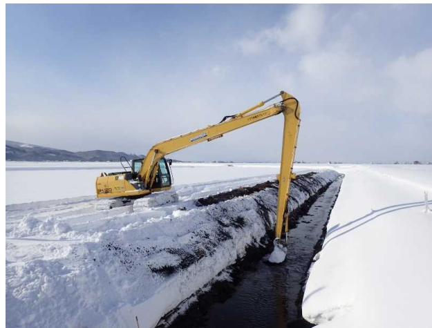
土砂掘削状況
