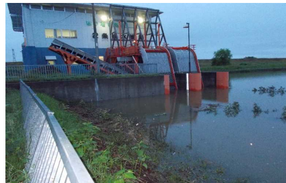
【排水機場の整備】 2条排水機場
