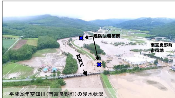
平成28年空知川(南富良野町)の浸水状況
