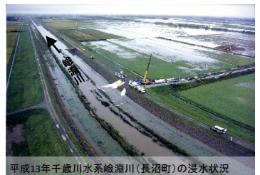
平成13年千歳川水系唼淵川（長沼町）の浸水状況
