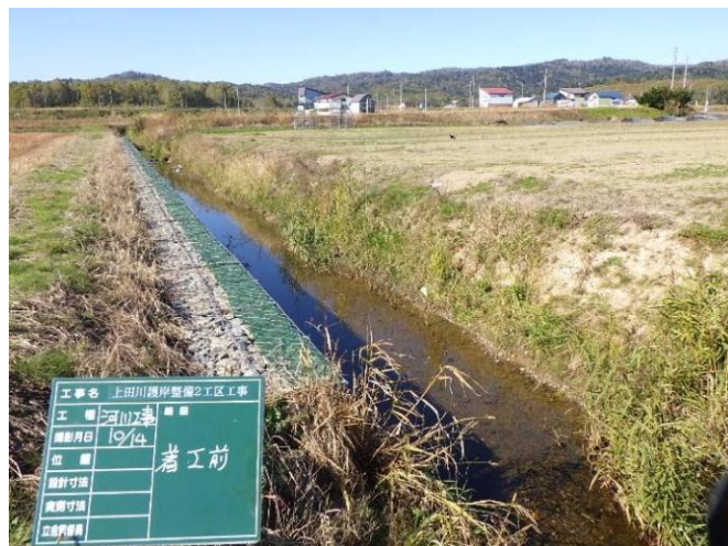
・上田川護岸整備工事
