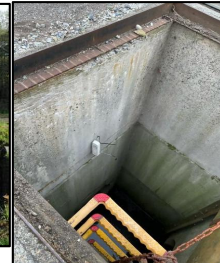
ワンコイン浸水センサの設置
