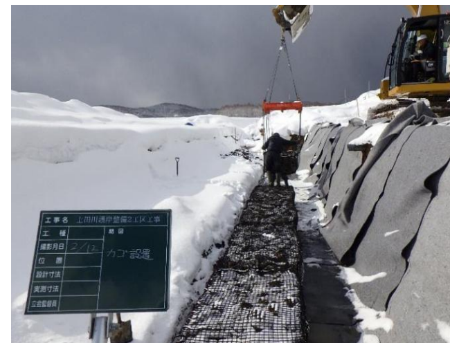
・上田川護岸整備工事
