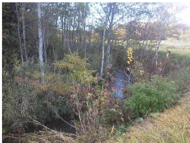
・御料川浚渫工事
