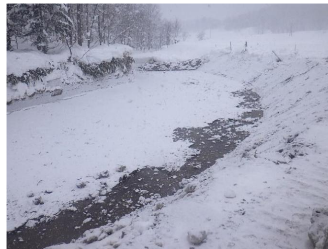
・御料川浚渫工事
