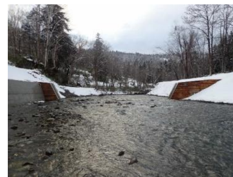
溪間工(治山ダム)の設置による溪床の安定化
