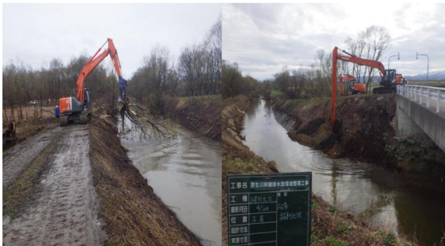
樹木伐採・河道掘削
