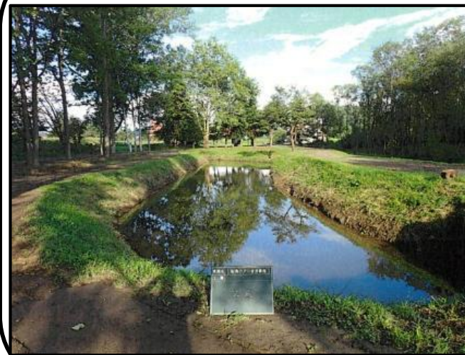
駄馬の沢川での伐開・浚渫
