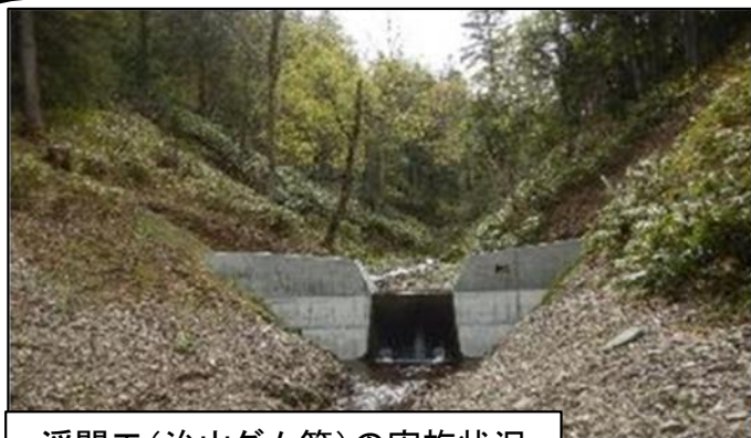
溪間工(治山ダム等)の実施状況
