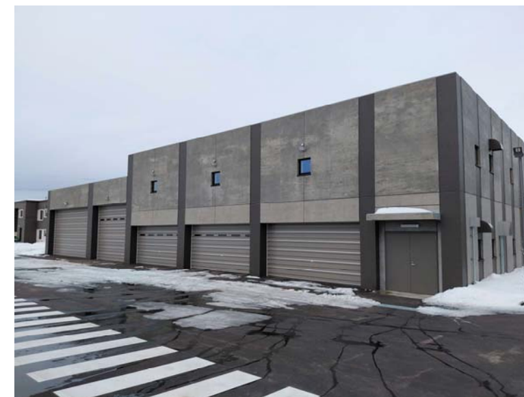
防災倉庫車庫棟
