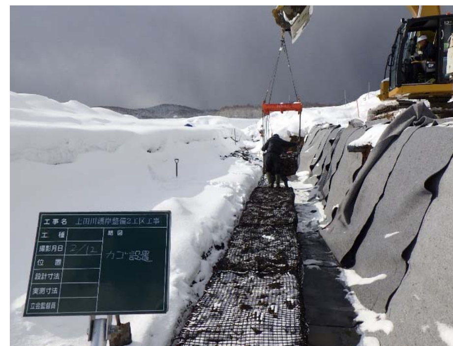
・上田川護岸整備工事
