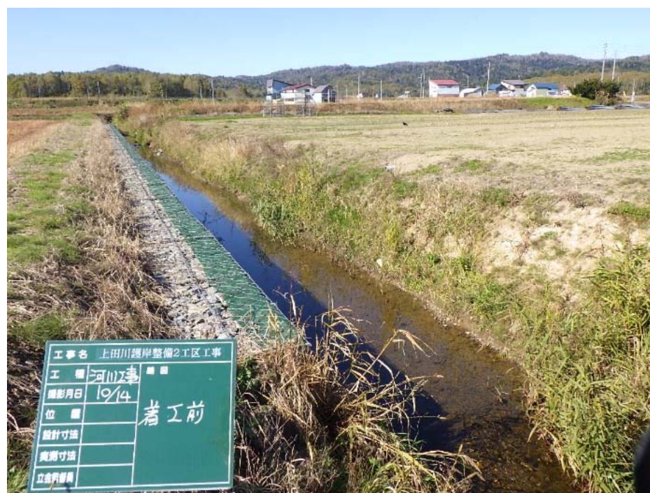
・上田川護岸整備工事
