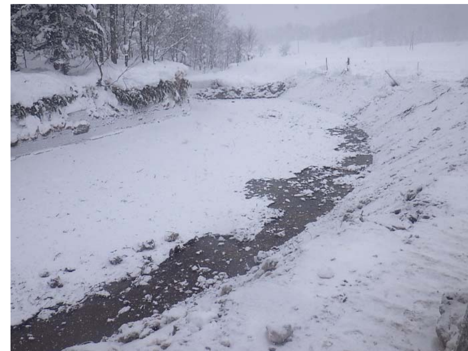
・御料川浚渫工事
