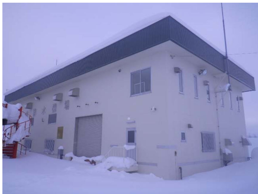
・碧水排水機場
