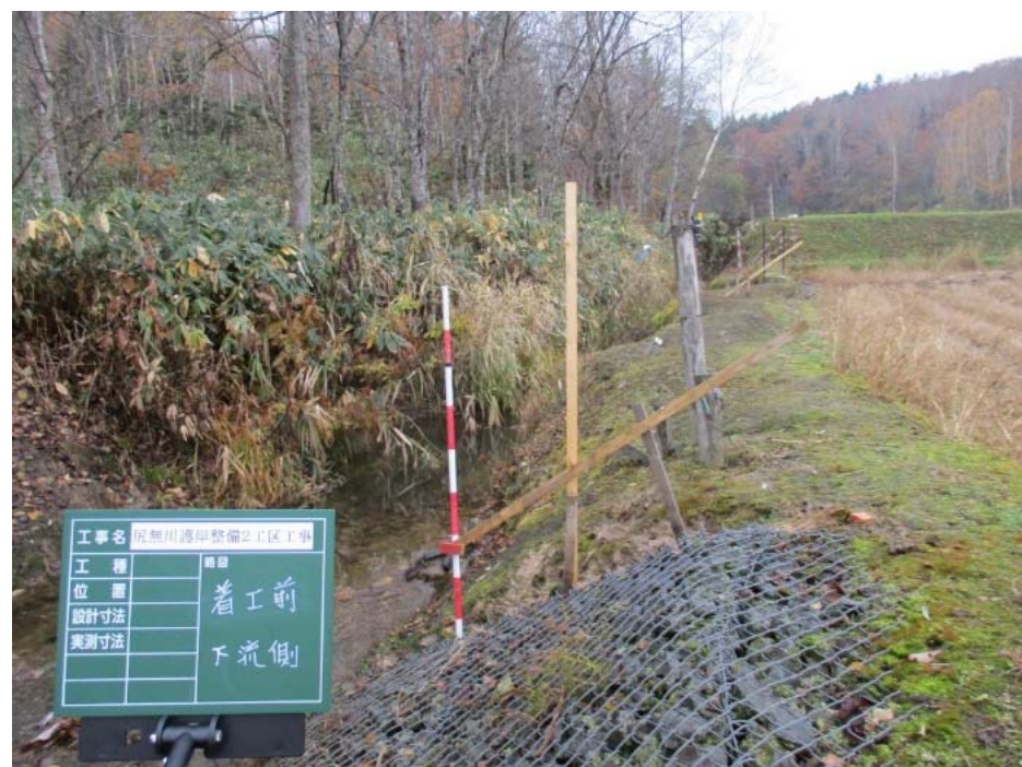
・尻無川護岸整備工事
