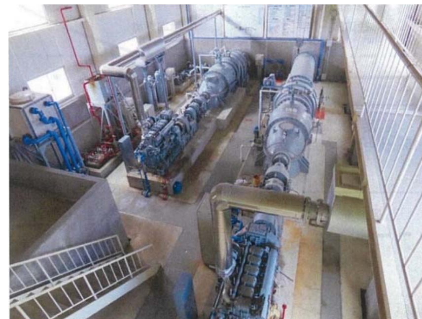
・碧水排水機場
