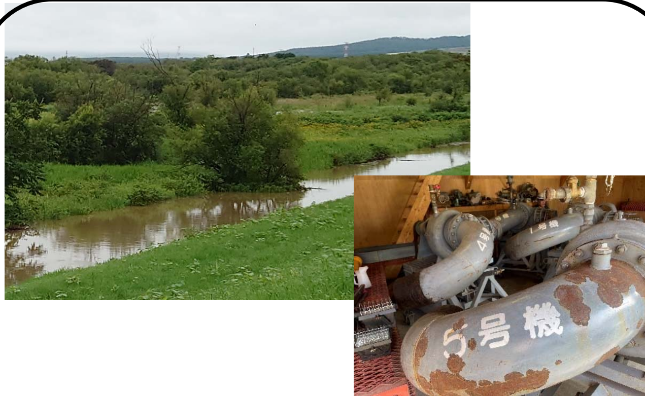
樹木伐採・河道掘削、排水ポンプ改修
