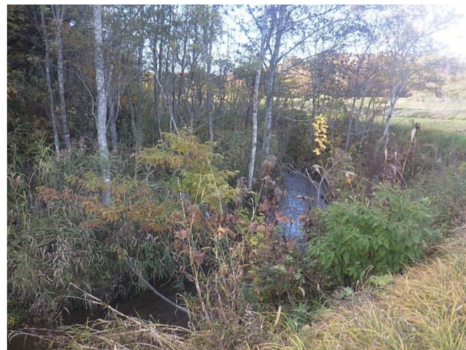
・御料川浚渫工事
