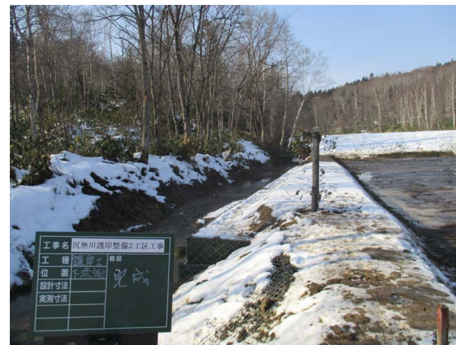
・尻無川護岸整備工事
