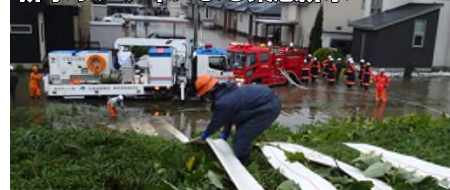
排水ポンプ車による緊急排水
