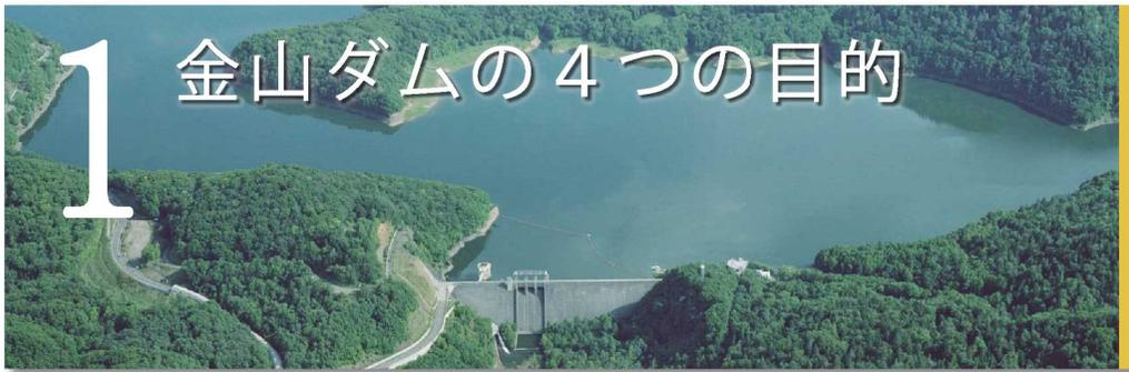
金山ダムは空知川の洪水を貯留して流域の洪水被害を軽減するほか、富良野地区、美唄・浦臼地区の農業用水を補給、そして滝川市等への上水道水の供給、さらに水力発電によって流域の産業の発展に貢献するという、4つの目的を持つ多目的ダム\*です。
