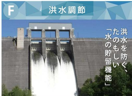
金山ダムは、昭和42年の管理開始から数多くの洪水被害を軽減してきました。特に激甚災害として指定された平成28年8月の豪雨災害では、下流の増水を最大で毎秒約1,320m<sup>3</sup>抑えました。これは金山ダムで抑えることが可能とされる流量の約1.7倍もの量でした。
