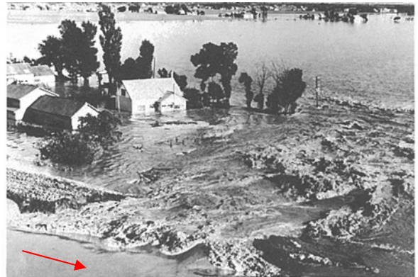
写真 2-4 石狩川左岸 大曲左岸築堤の越水破堤状況(美唄市)
