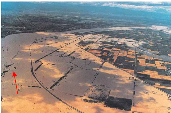
写真 2-5 石狩川右岸 下新篠津築堤の氾濫状況(江別市)
