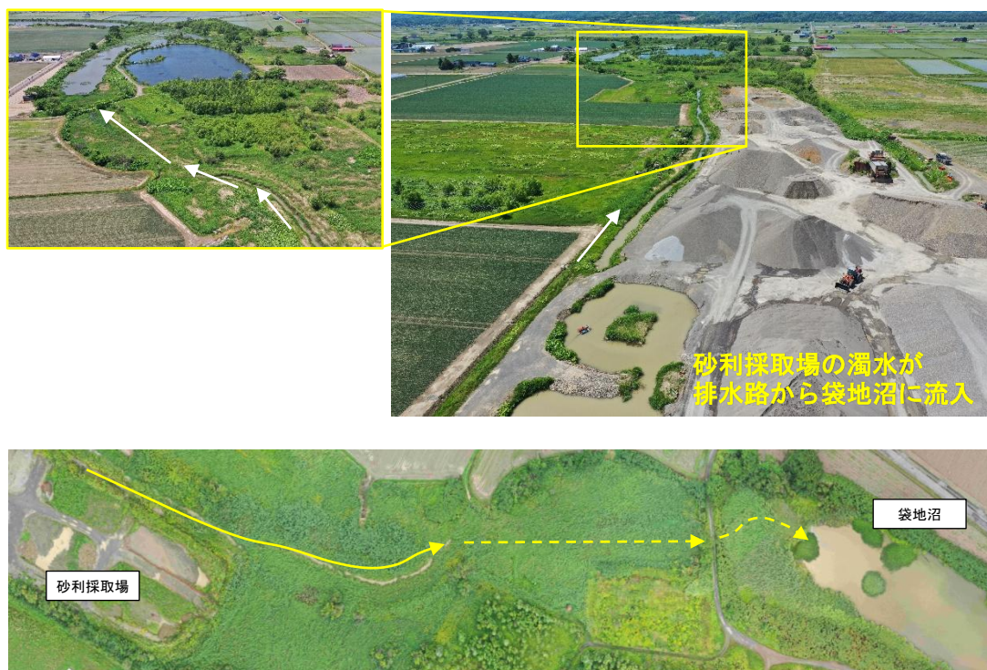
図 3-16 砂利採取場からの排水の流入状況
