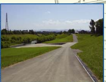
消火用水護岸
