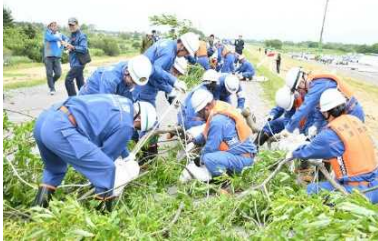
洗掘対策工法 (木流し工)
