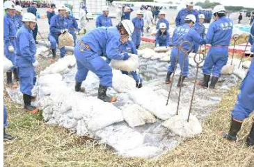
漏水対策工法 (月の輪工)
