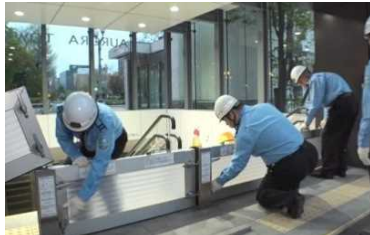
札幌都市開発公社による 地下浸水防止対策（録画）
