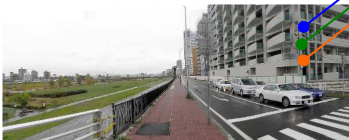
道路として占用されている豊平川の堤防 (南7条大橋上流左岸)
