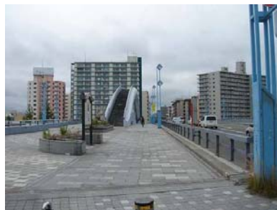
橋梁における視点場の例（幌平橋）
