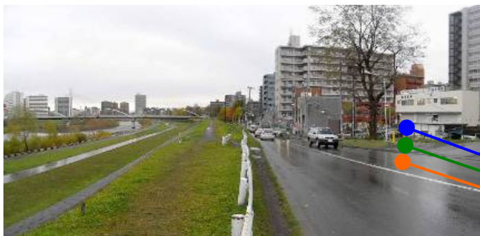
道路として占用されている豊平川の堤防 (豊平橋下流右岸)
