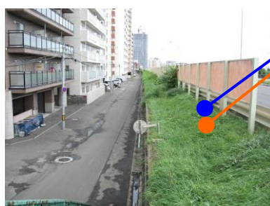
幌平橋付近（堤内側の状況）
