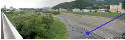
橋梁上からみる(藻岩橋から上流方向をみる)
