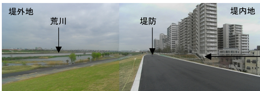
まちづくりと一体となった堤防整備の一例（荒川スーパー堤防）
