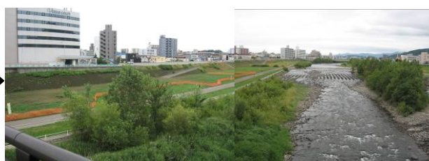
平成 19 年 8 月撮影 南 19 条大橋上流 3 年後、砂州上の植生の生育が進んでいる
