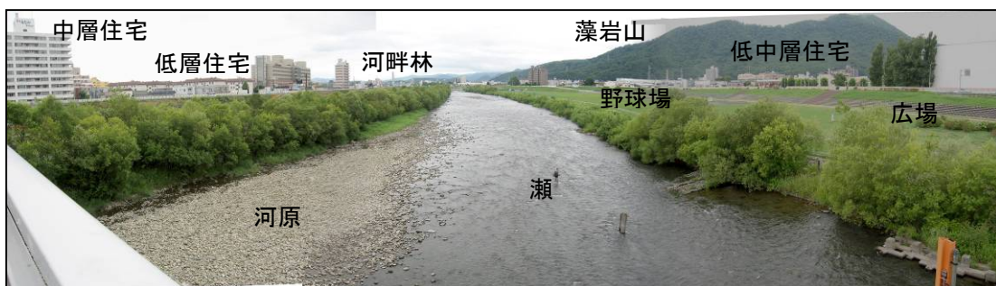
南 22 条大橋から上流方向をみる
