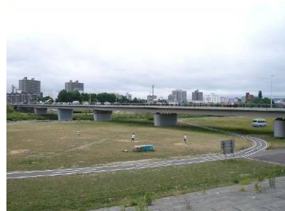
普通の橋の例（南大橋）
