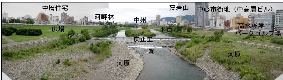
南7条大橋から上流方向をみる
