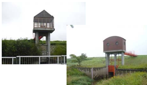
デザインの統一が図られていない樋門
