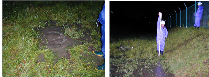
漏水調査イメージ
