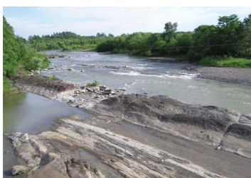
多良津橋 (KP34. 00) 付近
