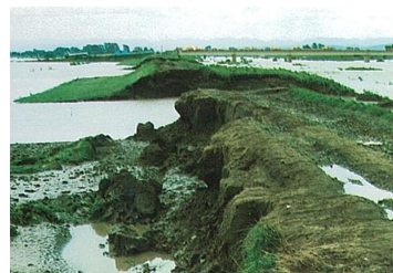
幌向川破堤状況（S56 洪水）
